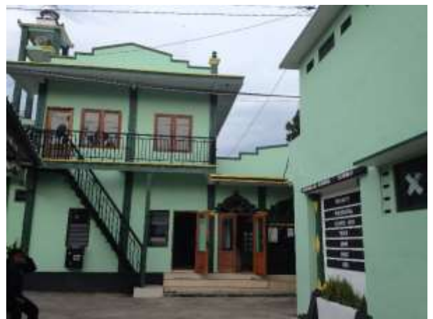
Gambar 7. Mushola di Ruang Periferi sebagai Bukti Kharisma Masjid Pathok Negara Dongkelan Tidak Mempengaruhi Ruang Periferi
