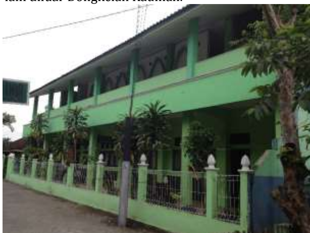
Gambar 9. Bangunan Berlantai Dua di Utara Masjid Pathok Negara Dongkelan yang Mengikis Teritori Ruang Masjid Pathok Negara Dongkelan
