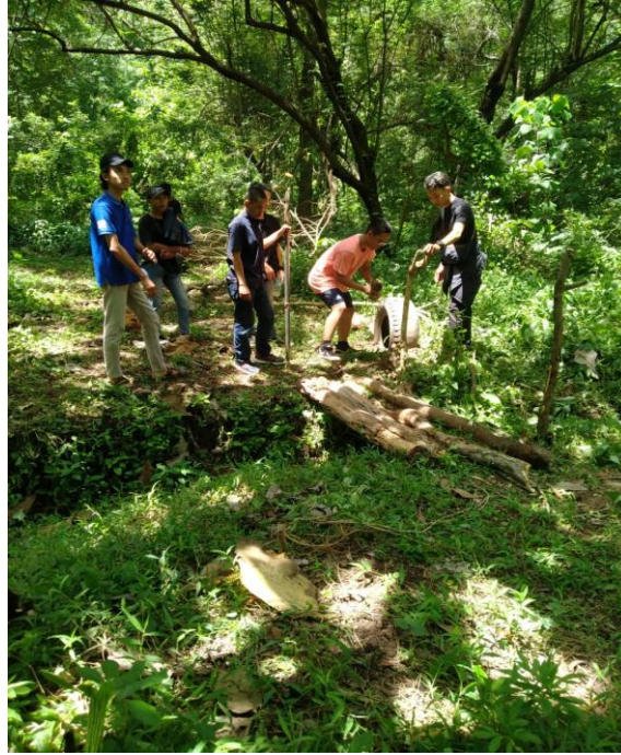
Gambar 2. Perbaikan Jembatan Arena Sepeda
