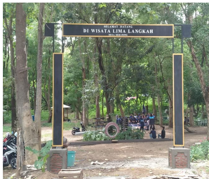
Gambar 3. Gapura Setelah Dipugar
