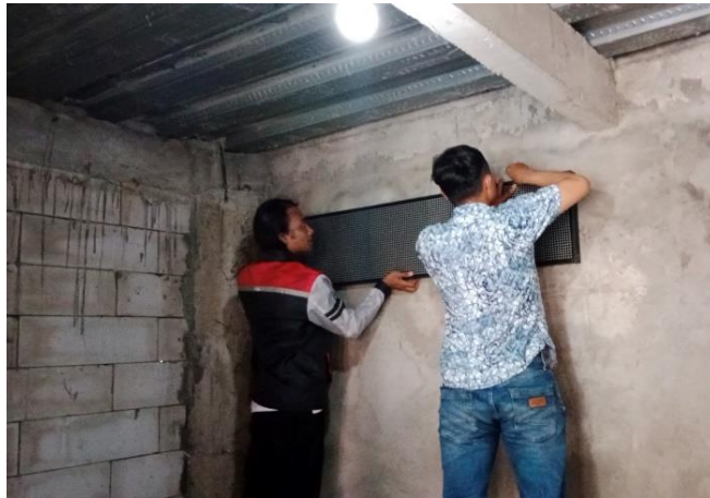
Gambar 3. Pemasangan Jam Digital dan Running Text
