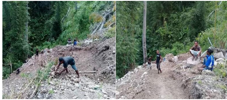
Gambar 2. Lokasi air terjun Binafui Taman Mataru, terlihat pengambilan material untuk bahan bangunan.
