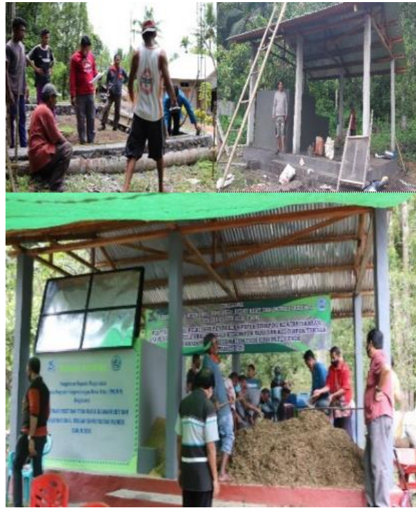
Gambar 1. Proses Pembangunan Rumah Kompos
